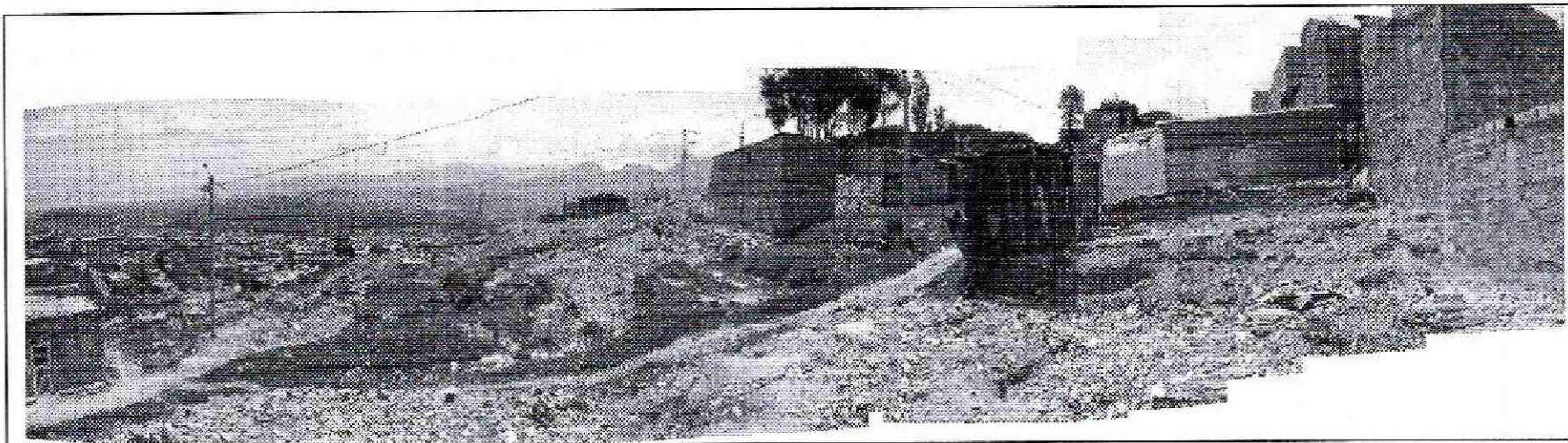
Fotografía 7. Vista general de la zona afectada por el proceso identificado en Diciembre de 2011 en el barrio Cedritos del Sur I y que se ubica en la parte posterior del predio de la Carrera 18C No 77B - 24 Sur. Se observa que muchas de las viviendas han sido demolidas.
