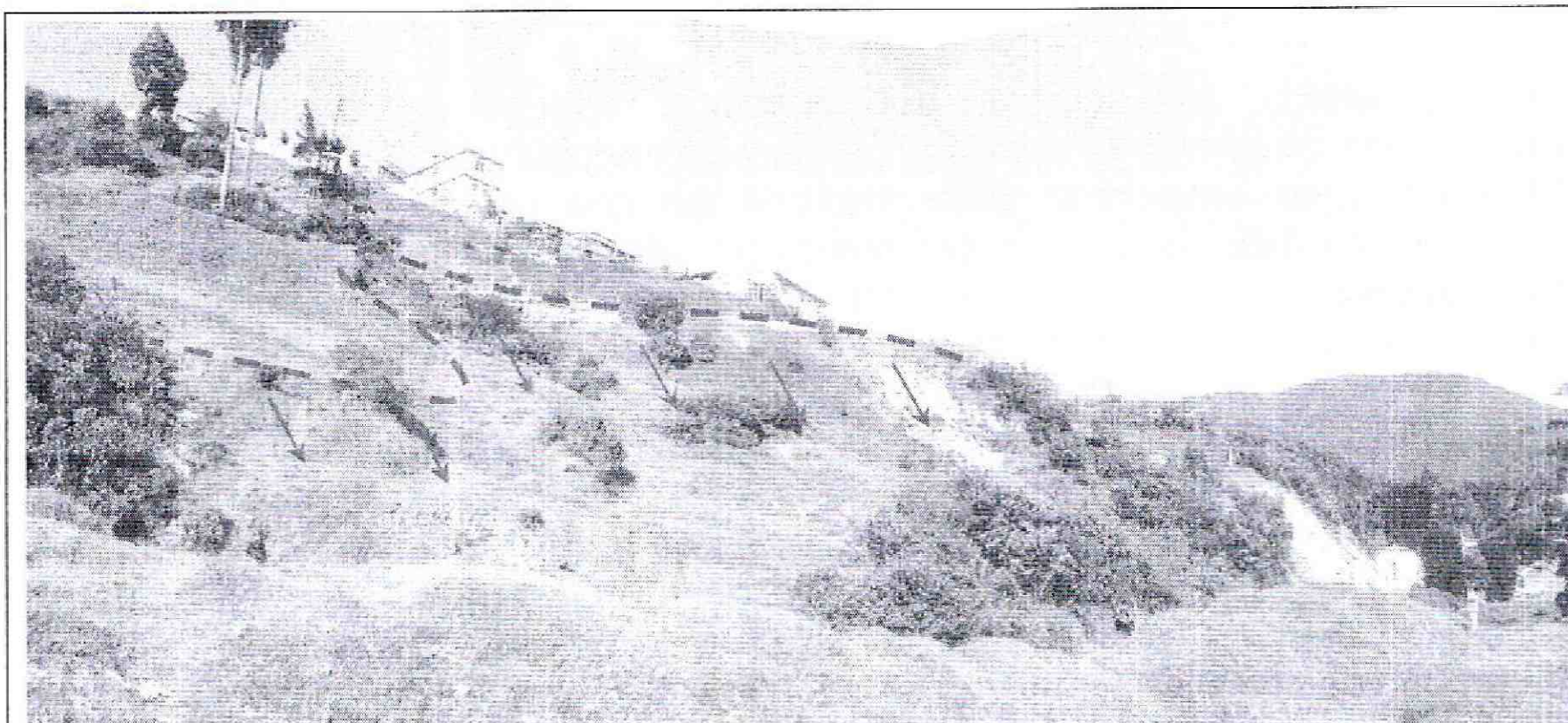
Foto 2. Vista del tercer proceso de remoción en masa de carácter general identificado en el DI-6224, localizado en el Barrio El Dorado de la Localidad de Santa Fe (costado Sur-Oriental de la Urbanización Parque de la Roca), correspondiente posiblemente a una reptación, teniendo en cuenta la presencia de deformaciones sobre el terreno consistente en lóbulos y escarpes e inclinación anormal de individuos arbóreos emplazados sobre la ladera en comento.
