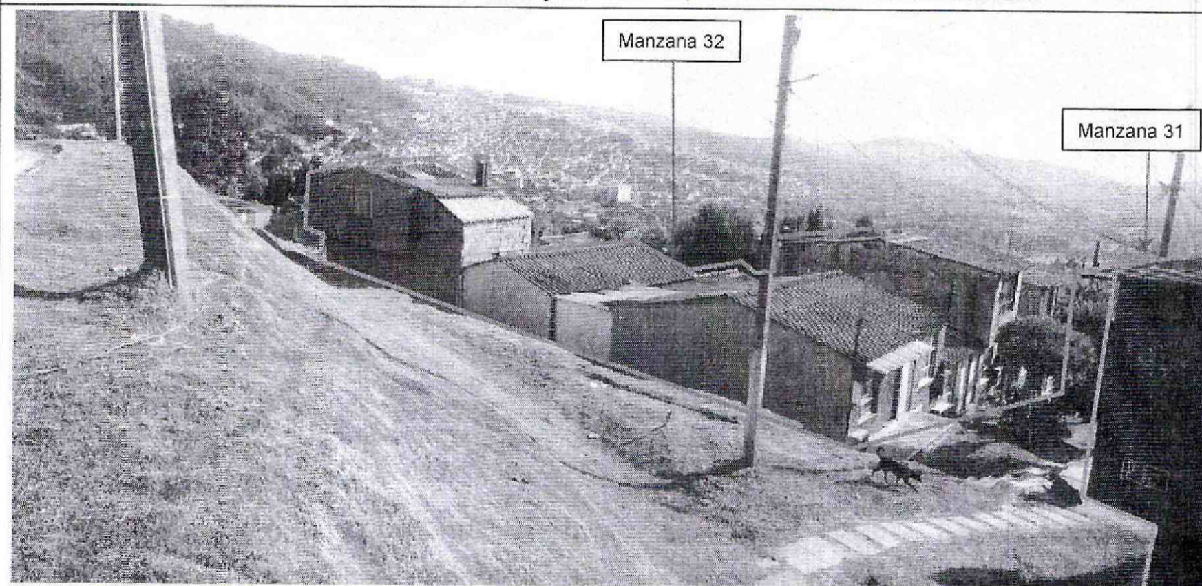
Foto 5. Vista de las edificaciones que hacen parte de las Manzanas 32 y 31 (MZ 65 y 64 respectivamente según la UAECD), de la Urbanización Parque de la Roca de la Localidad de San Cristóbal, donde se aprecia que corresponden edificaciones de uno y dos niveles, con cubierta en fibro-cemento.
