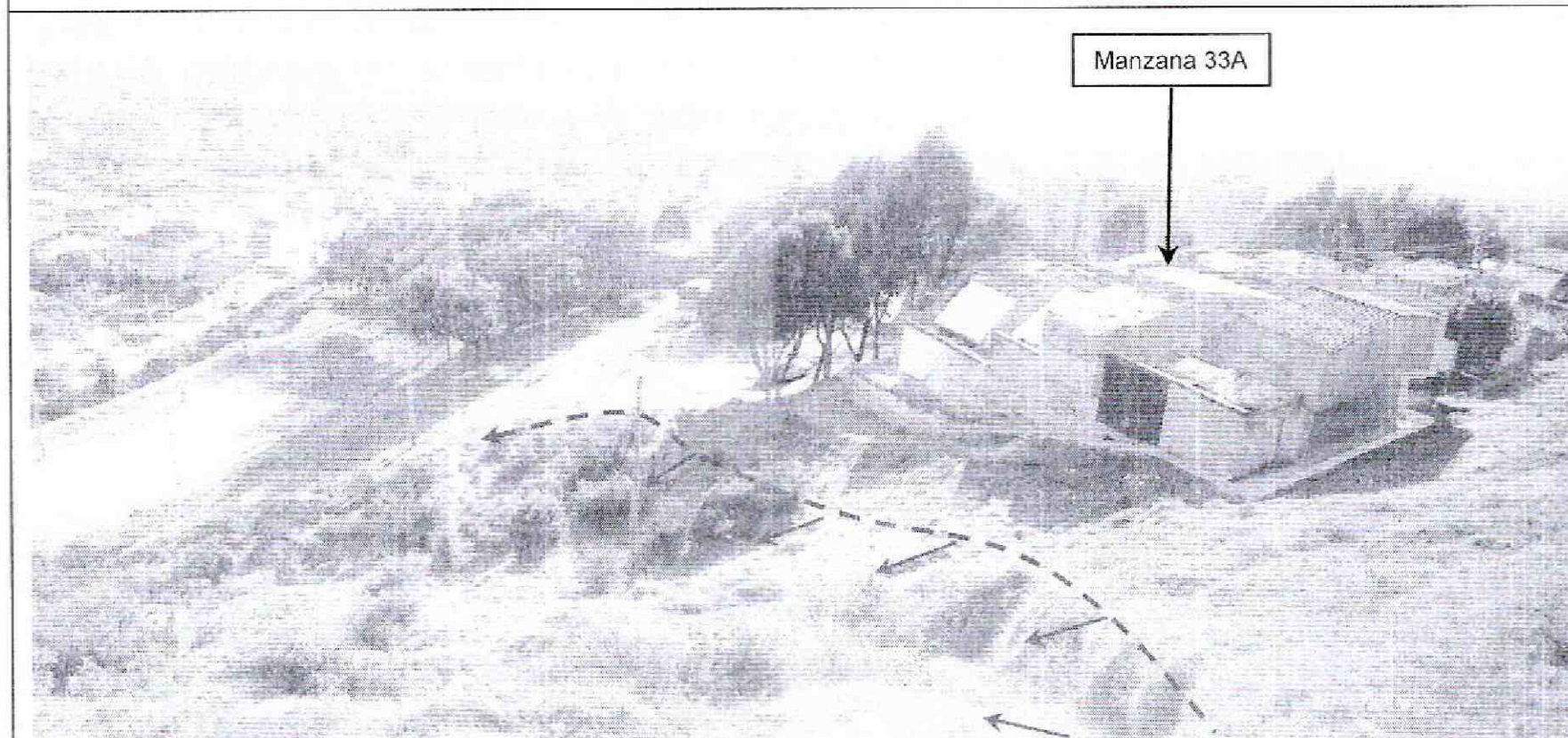
Foto 3. Vista del proceso de remoción en masa identificado en los Diagnósticos Técnicos DI-5396 y DI-6356 localizado hacia el costado Sur-Oriental de la Urbanización Ciudadela Parque de la Roca, donde se aprecia el terreno ondulado, escarpes y grieta de tracción.
