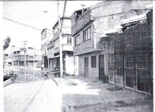
Fotografía No. 2. Panorámica del predio de la Transversal 74 F No 62 – 10 SUR. Se observa pendiente del sector y vía pavimentada.
