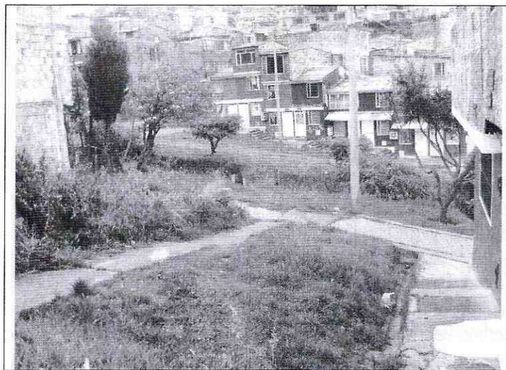
Fotografía No. 3. Vista sobre la TV 13B Este (vía peatonal), al fondo se observa el cauce de la Quebrada Seca San Cristóbal.
