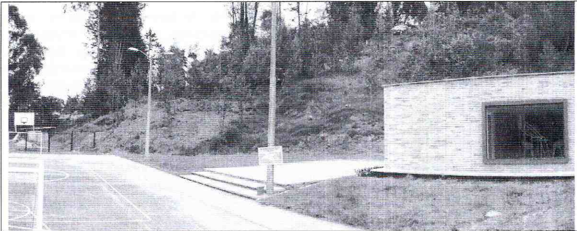
Fotografía No. 3. Detalle del deslizamiento localizado en el sector oriental, se observa la masa deslizada junto a la cancha de baloncesto del proyecto.
