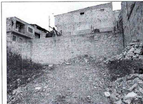
Fotografía No. 1. Predio donde se desarrollará el proyecto ubicado en la Cra 8 A Este No. 54 D - 04 Sur.
