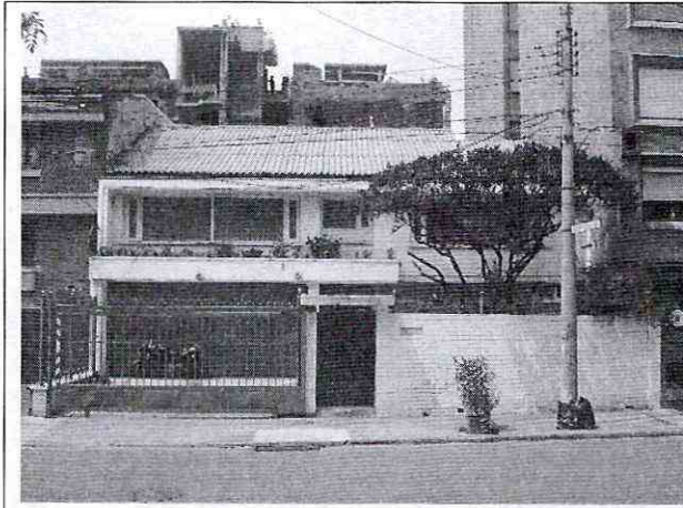
Fotografía No. 1. Predio ubicado en la Carrera 1 Este 76A 75 de la localidad de Chapinero.
