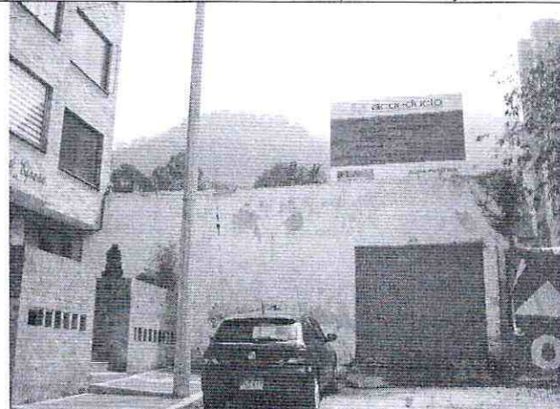
Fotografía No. 8. Predio aledaño a los predios del proyecto, en donde según la valla de identificación se encuentra una Estación de Bombeo y Tanque de Almacenamiento Chapinero de propiedad de la EAAB.
