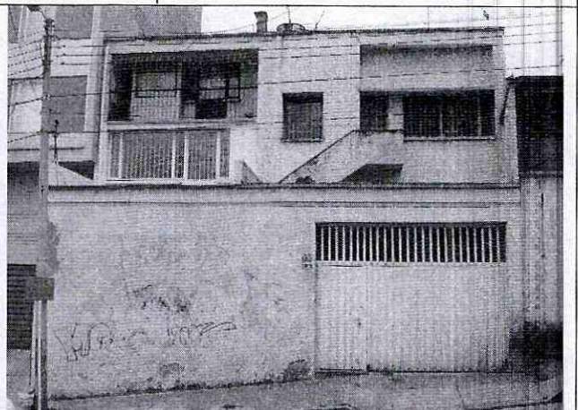
Fotografía No. 4. Predio ubicado en la Calle 64 2 34 de la localidad de Chapinero.
