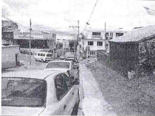
Fotografía No. 3. Vista (E - O). Panorámica de la Calle 120A. Se observa vías pavimentadas. Cuenta con una pendiente media a alta y sistemas de alcantarillado. Se observa un sector consolidado y comercial.
