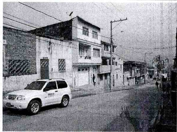
Fotografía No. 2. Panorámica de la Carrera 5 Este, la cual se encuentra pavimentada.
