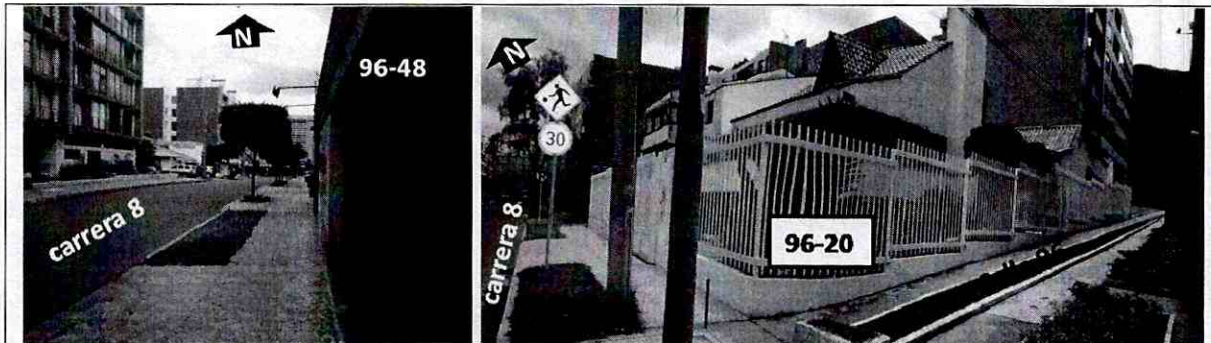
Fotografía 1. Panorámicas del proyecto en la en la carrera 8 con calle 96 números 96-20, 96-36 y 96-48
