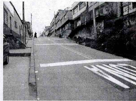
Fotografía No. 4. Panorámica del sector sur de la Carrera 5 Este.
