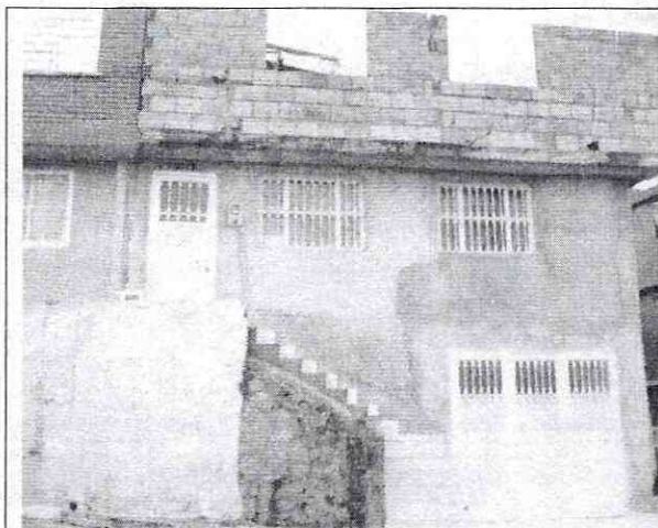
Fotografía No. 1. Predio en donde se desarrollará el proyecto, ubicado en la TV 10 Este 38-72 Sur de la Localidad de San Cristóbal.
