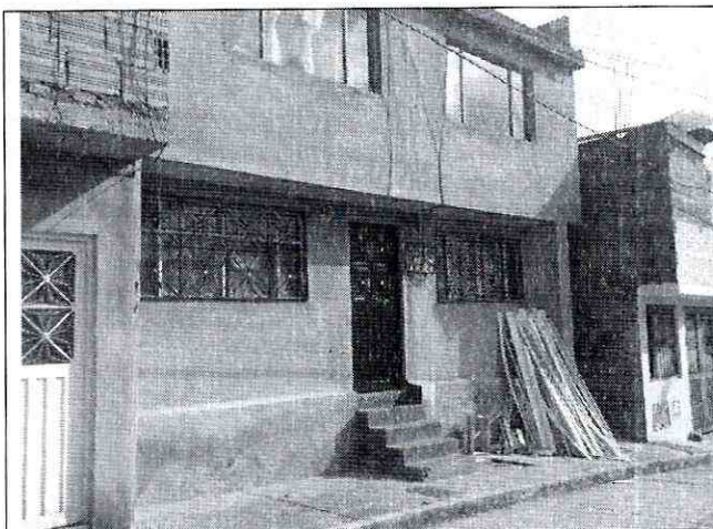
Fotografía No. 1. Predio en donde se desarrollará el proyecto, ubicado en la Carrera 1A Este No 49C-32 Sur de la localidad de Rafael Uribe Uribe.
