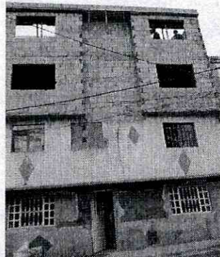
Fotografía No. 4. Vista actual del predio de la solicitud. Se observa que está construido en mampostería sin confinar, con placas macizas de un espesor aproximado de 10 cm.
