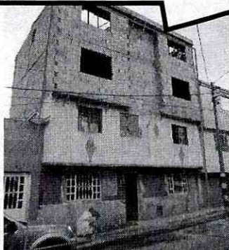
Fotografía No. 3. Vista actual del acceso predio de la Calle Diagonal 32D Bis A Sur No 12J - 15 del barrio Resurrección de la Localidad de Rafael Uribe donde se desarrollara el proyecto.
