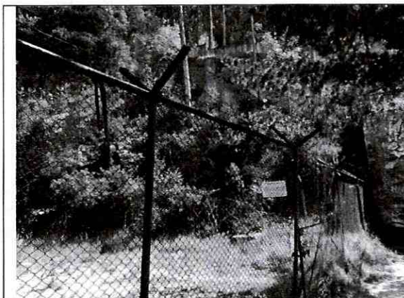
Fotografía No. 1 vista desde la Carrera 3 en el costado oriental de los predios en donde se desarrollará el proyecto, ubicado en Transversal 3 No 87-32/26 de la localidad de Chapinero.
