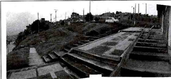
Fotografía No. 5. Vista de la Transversal 73K. Se observó la presencia de rellenos antrópicos poco consolidados y cubiertos por pastos, así como elementos urbanísticos, senderos peatonales que delimitan la zona del proyecto.
