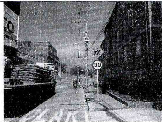
Fotografía No. 4. Panorámica del costado occidental de la Calle 14 Sur.
