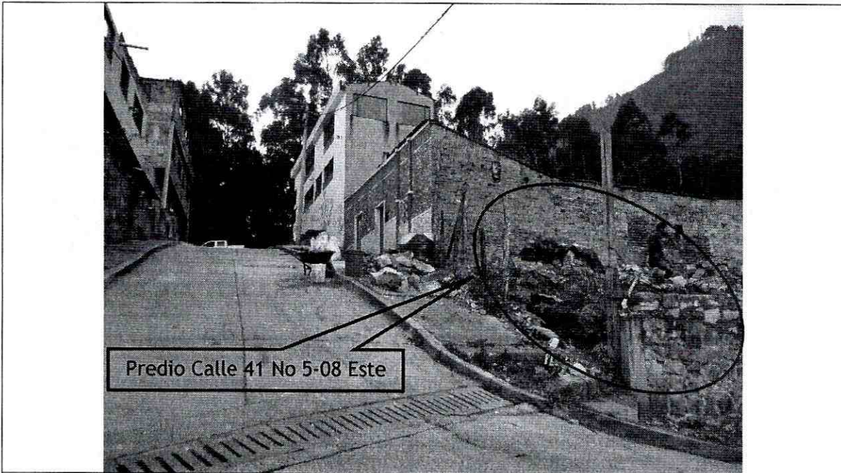
Fotografía No. 2. Vista del predio desde la Carrera 5 Este.
