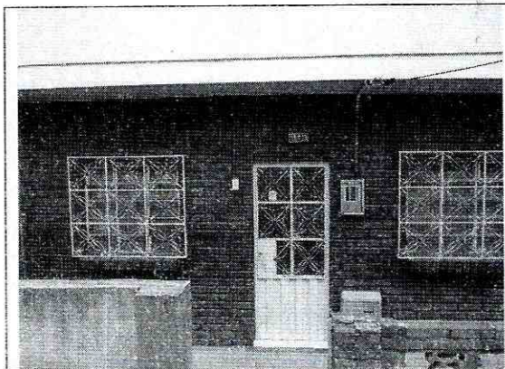
Fotografía No. 1. Primer nivel de la edificación emplazada en donde se desarrollará el proyecto ubicado en la Diagonal 38 G Sur No. 11 A - 13.
