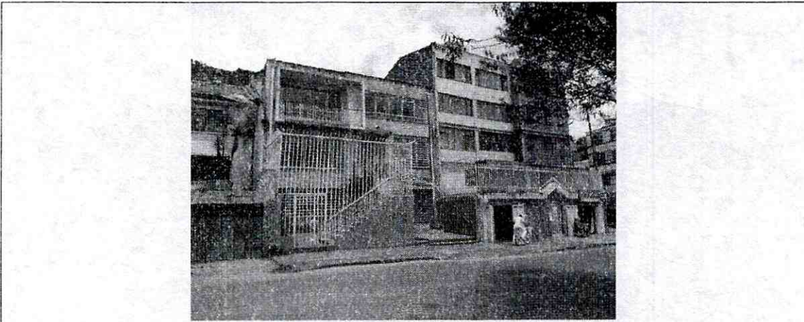
Fotografía No. 1. Predios en donde se desarrollará el proyecto, ubicado en la Transversal 3 No 51 – 16 / 32 / 38 de la Localidad de Chapinero.
