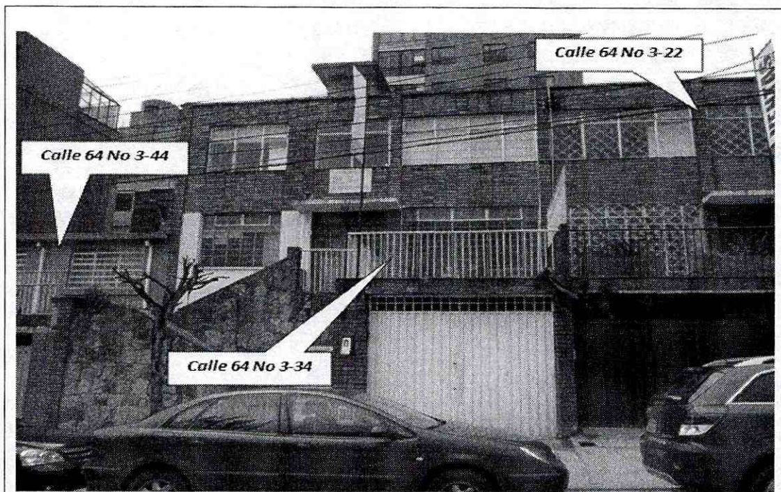
Fotografía No. 2. Predio en donde se desarrollará el proyecto, ubicado en la Calle 64 No 3-14/22/34/44 de la Localidad de Chapinero. El sector aledaño al área del nuevo proyecto se encuentra consolidado con una alta densidad urbanística y evidencia de servicios públicos completos.
