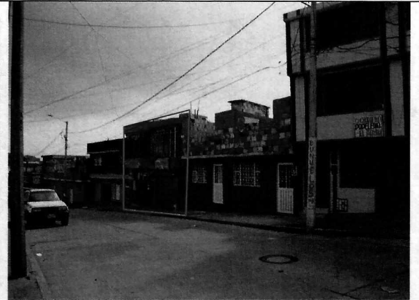
Fotografía No. 2. Vista del sector donde se ubica el proyecto de la Carrera 12D Este No. 58-81 Sur.
