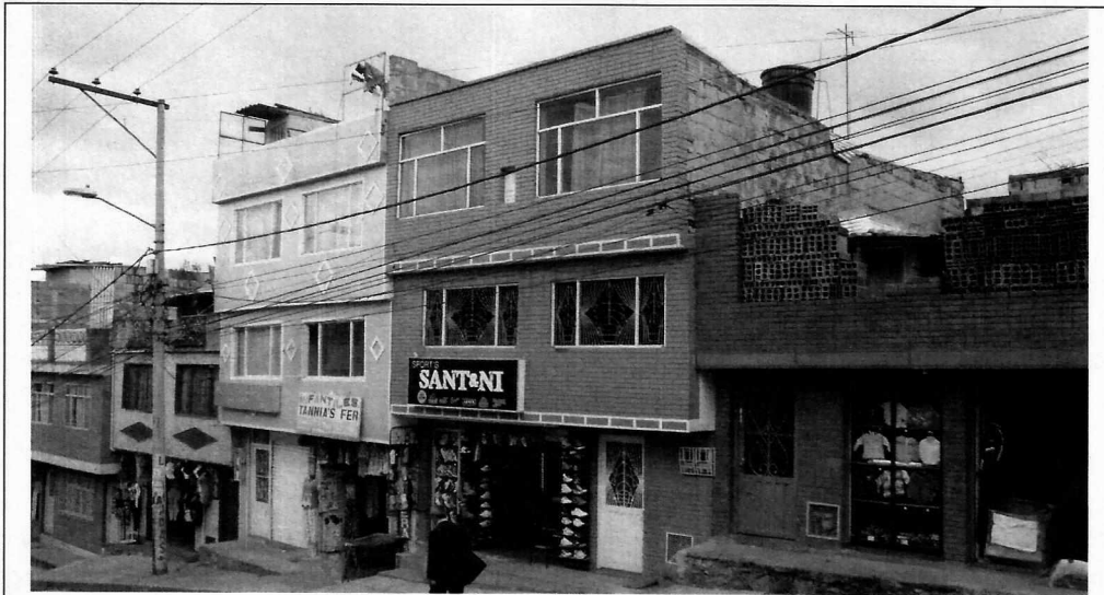
Fotografía No. 1. Predio en donde se desarrollará el proyecto, ubicado en la Calle 48 X Sur No. 3B - 16, de la Localidad de Rafael Uribe Uribe
