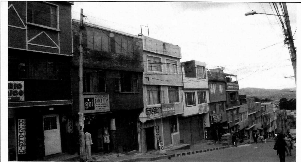
Fotografía No. 2. Vista de la Calle 48X Sur se evidencia un sector consolidado cuyo uso es principalmente residencial, algunos con uso comercial en el primer piso.
