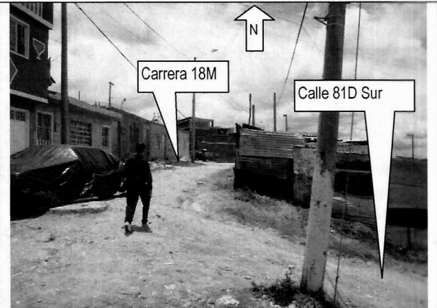
Fotografía No. 2. Vista de la intersección de la Carrera 18M y la Calle 81D Sur se evidencia un sector en proceso de consolidado con vías en afirmado y algunas viviendas en materiales de recuperación.
