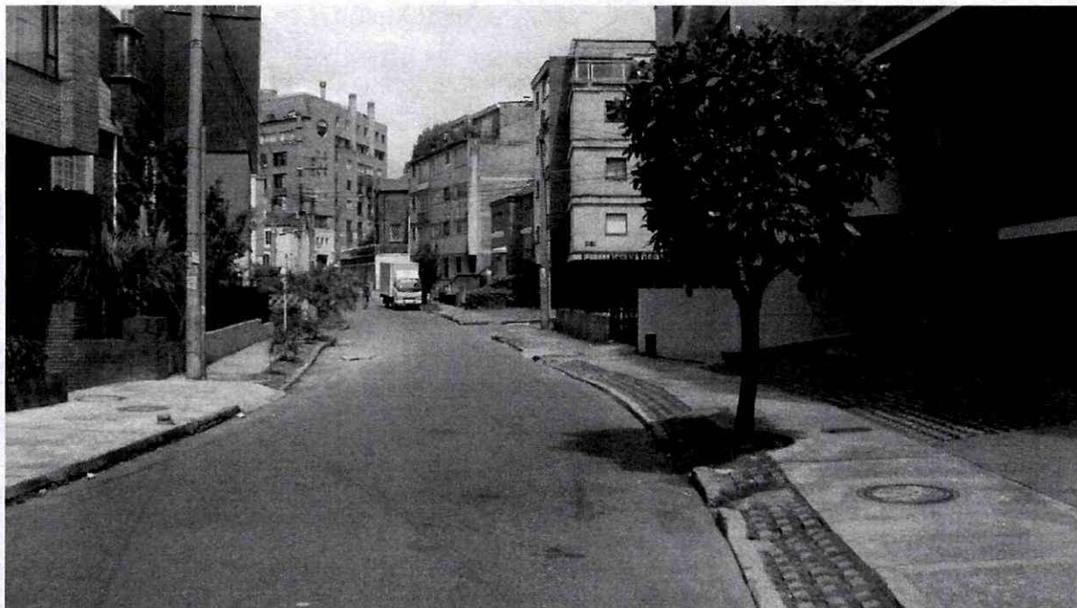
Fotografía No. 2. Vista de la Carrera 4 A entre la Calle 55 y la Calle 56, se evidencia un sector consolidado.
