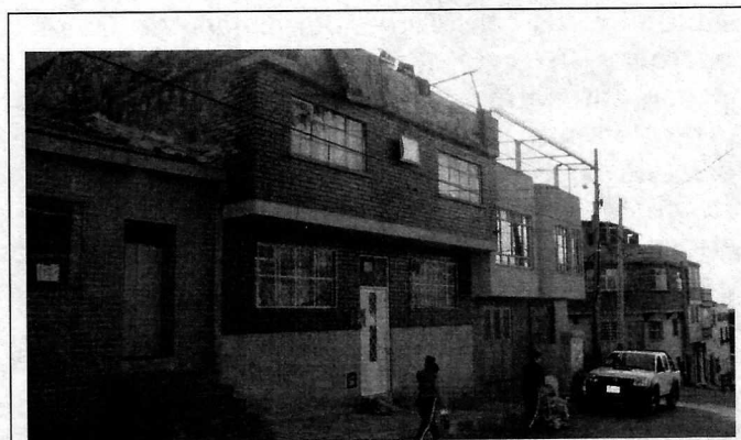
Fotografía No. 1. Predio en donde se desarrollará el proyecto, ubicado en la Calle 17 Sur No. 7 - 65 Este, de la Localidad de San Cristóbal
