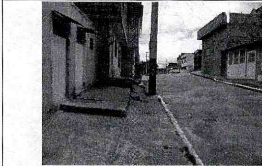
Fotografía No. 2. Vista de la Transversal 12 B Este hacia el norte, se evidencia la vía pavimentada y la tipología de las viviendas del sector.
