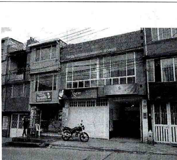
Fotografía No. 1. Predio del proyecto ubicado en la Calle 20A Sur No 2-14, de la Localidad de San Cristóbal.
