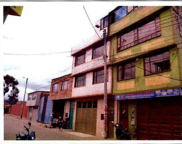
Fotografía No. 2. Panorámica de la Calle 127A. Se observa tipología de viviendas en las calles interiores del desarrollo, puede verse la vía pavimentada con pavimento flexible y la presencia de sumideros.
