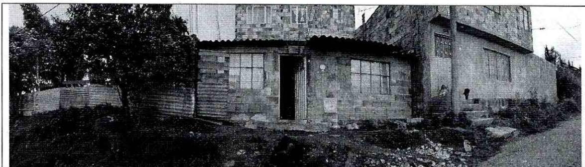
Fotografía No. 1. Predio en donde se desarrollará el proyecto ubicado en la Carrera 15 A Este No. 76 C-08 Sur de la Localidad de Usme.
