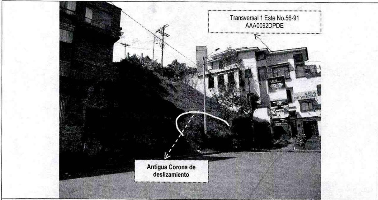
**Fotografía No. 1.** Predio en donde se desarrollará el proyecto ubicado en la Transversal 1 Este No. 56-91, Localidad de Chapinero. Se observa una cicatriz de un antiguo deslizamiento en el lote vacío contiguo al predio objeto del concepto técnico.
