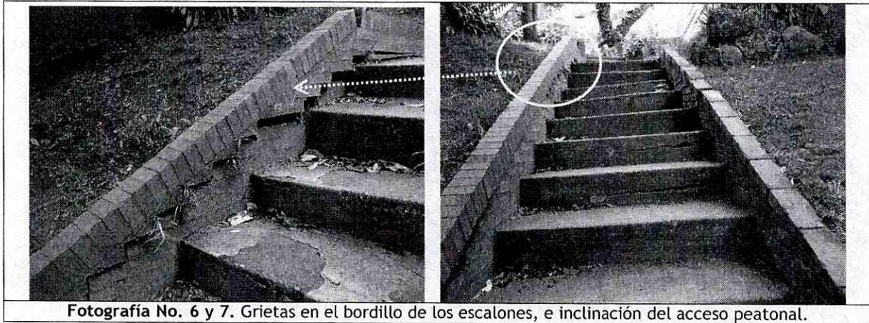
Fotografía No. 6 y 7. Grietas en el bordillo de los escalones, e inclinación del acceso peatonal.
