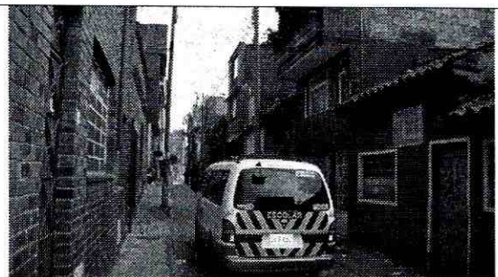
Fotografía No. 2. Vista del sector donde se localiza el proyecto de Calle 32 No. 4A-03 se evidencia un sector consolidado cuyo uso es principalmente residencial.
