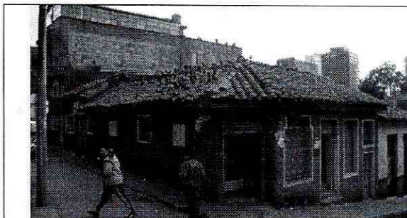
Fotografía No. 1. Predio en donde se desarrollará el proyecto, ubicado en la Calle 32 No. 4A-03 de la localidad de Santa Fe.
