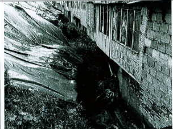
Fotografía No. 4. Afectación por proceso de remoción en masa en la parte posterior del predio del proyecto ubicado en la Calle 20 A Sur # 2 – 14, de la Localidad de San Cristóbal.
