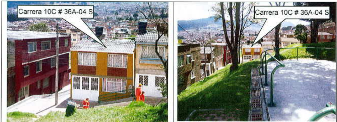
Fotografías No. 1 y 2. Aspecto del predio donde se desarrollará el proyecto en la Carrera 10 C No. 36- 04 Sur y sus alrededores, vistos desde el costado nor occidental del lote evaluado.
