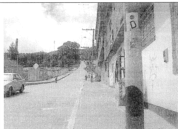
Fotografía No. 2. Panorámica de la Calle 32F Sur. Se observa pendiente del sector y vía pavimentada.
