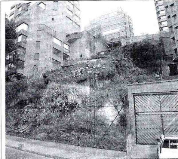
Fotografía No. 1. Predio del proyecto "Mirador del Chicó" ubicado en la Transversal 4 C No. 89-35, de la localidad de Chapinero.
