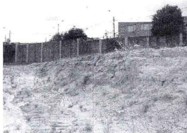
*Fotografía No. 6: Esquina noroccidental del predio donde se observa un talud bajo con procesos de erosión.*
