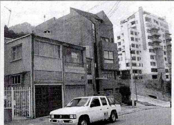
Fotografía No. 2. Edificación existente al costado sur del predio de interés.
