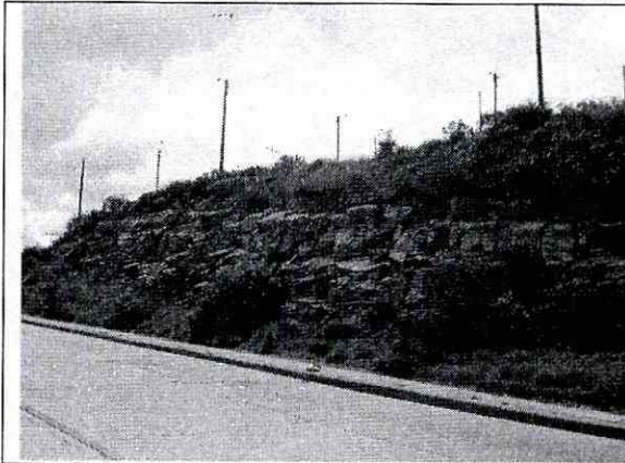
Fotografía No. 3. Areniscas fracturadas de la Formación Guadalupe aflorando al costado norte del predio.
