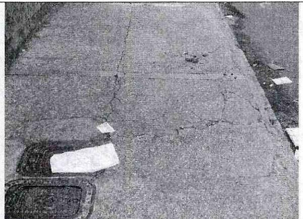
Fotografía No. 2. Grietas en andén aledaño al predio donde se localiza el proyecto, asociadas con deficiencias constructivas y uso inapropiado, más que a procesos de inestabilidad activos.
