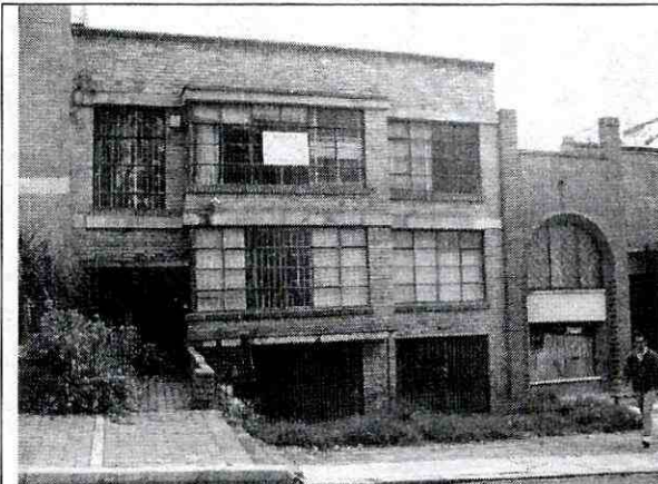
Fotografía No. 1. Predio del proyecto localizado en la Calle 68 No. 4A - 69 Barrio Granada, localidad de Chapinero.
