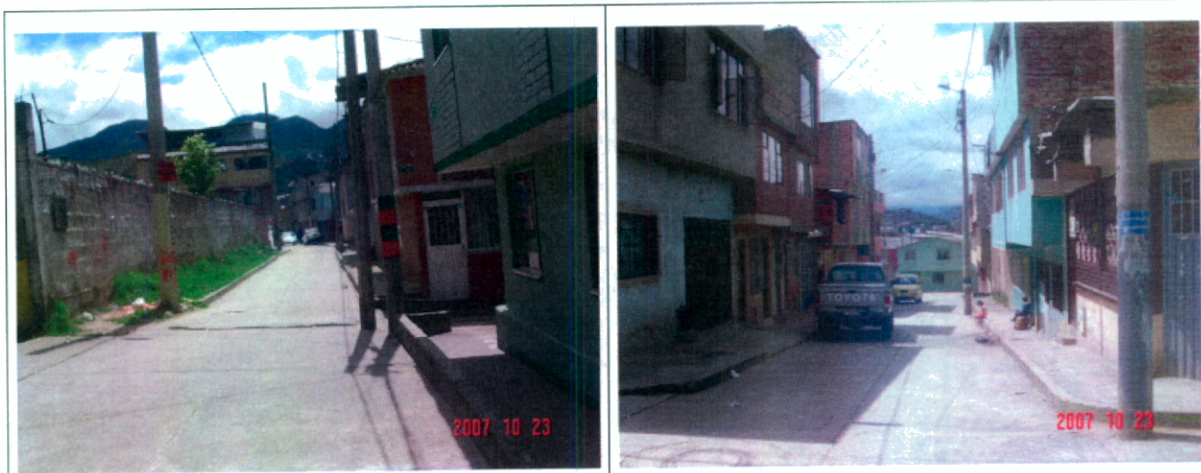
Fotografía No. 1 y No. 2 Aspecto de las vías pavimentadas dentro del desarrollo El Mirador I. Diagonal 48 X Sur y Transversal 5 T respectivamente.
