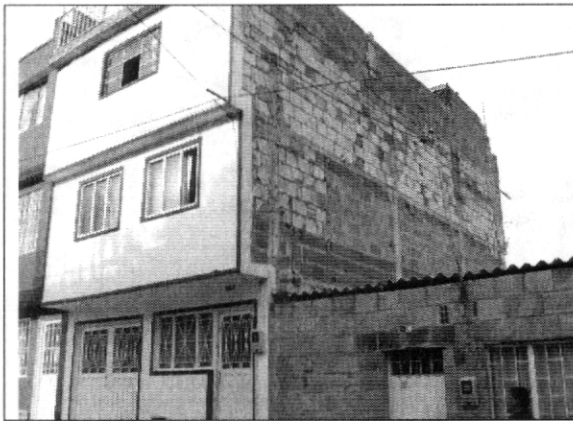
Fotografía No.1. Diagonal 49D Sur No.12-30, Predio donde se busca adelantar el proyecto.
