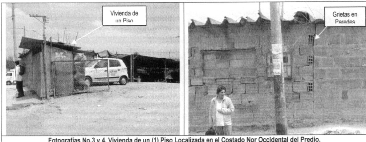
Fotografías No.3 y 4. Vivienda de un (1) Piso Localizada en el Costado Nor Occidental del Predio.
