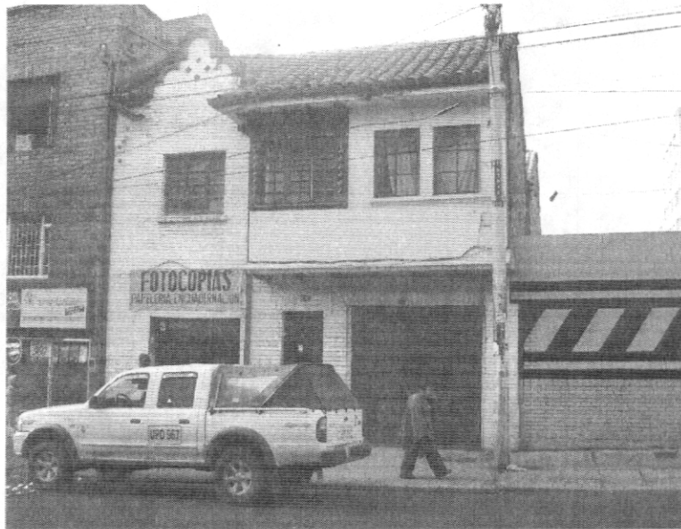
Foto No. 1. Aspecto de los predios donde se llevará a cabo el proyecto de la calle 46 No. 8 – 42
