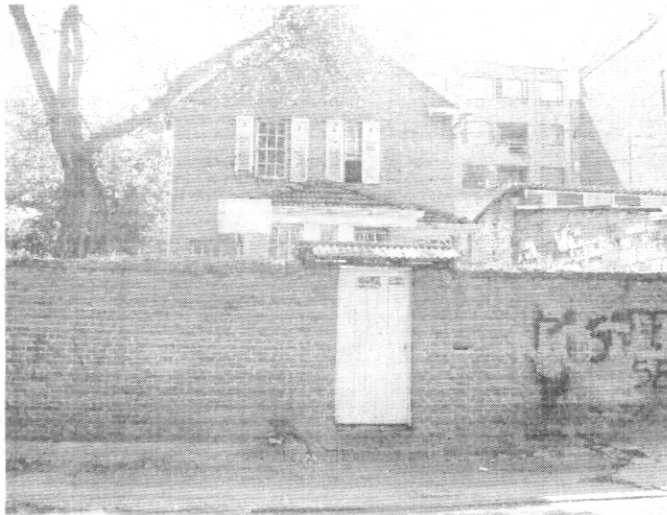
Foto No. 1. Aspecto del predio donde se llevará a cabo el proyecto de la CR 4A # 66 - 90/96. Vivienda destinada a restauración
