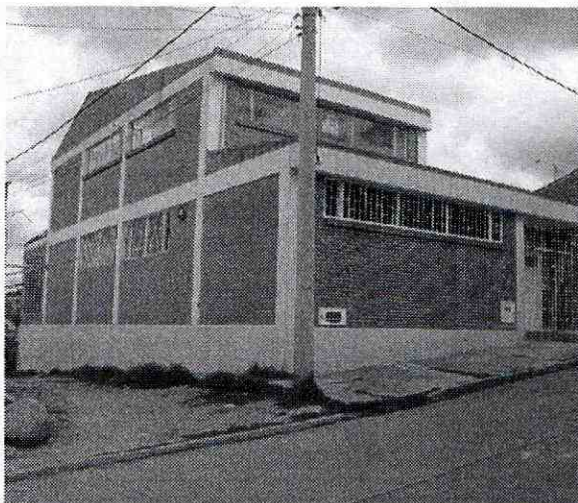
Foto 1. Aspecto de la estructura que conforma la Casa Vecinal Monteblanco.
