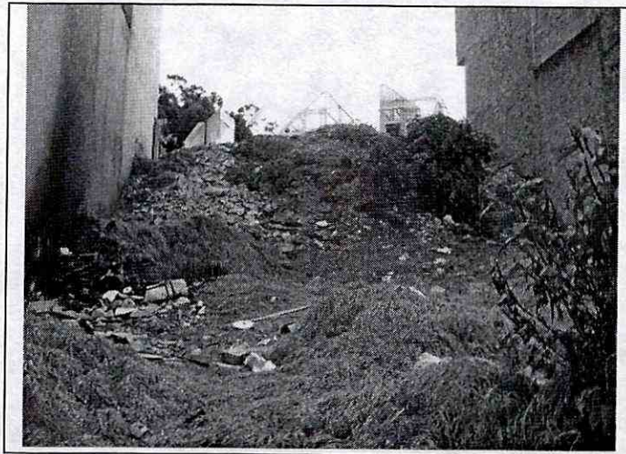
Fotografía No. 2. Depósitos de escombros y basuras, en la parte superior del predio de la Transversal 4 # 43 - 85
