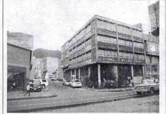
Fotografías No. 9 y No. 10: AK 14 por CL 20 costado suroriental. Edificación en proceso de deterioro físico. En la actualidad la edificación que esta en desuso ha sido intervenido en vanos de ventanas de los pisos superiores. Fotografía No. 9 tomada del CT-5999.
