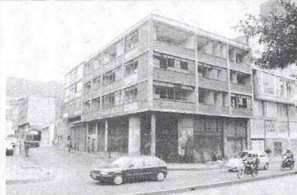
Fotografías No. 9 y No. 10: AK 14 por CL 20 costado suroriental. Edificación en proceso de deterioro físico. En la actualidad la edificación que esta en desuso ha sido intervenido en vanos de ventanas de los pisos superiores. Fotografía No. 9 tomada del CT-5999.
