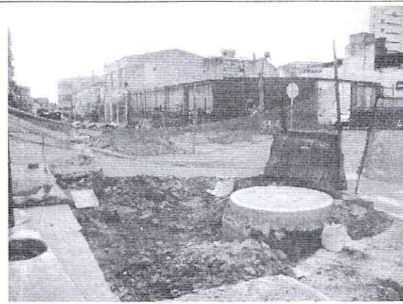
Fotografía No. 16: KR 13 A entre CL 20 y CL 22. Obras de infraestructura en vía pública.
